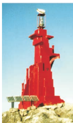
3492 LAJE DA CONCEIÇÃO
